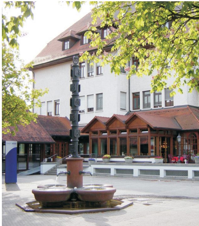
Blick vom Untertorplatz auf das Gebäude der Stadtwerke Radolfzell GmbH mit Kunden-Center.
