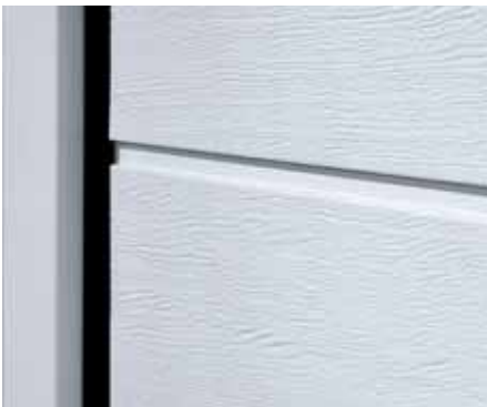
Dauerelastische und witterungsbeständige Dichtungen an der Zarge
