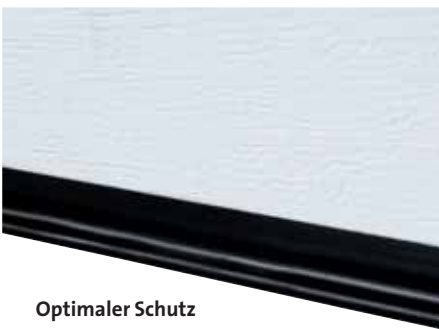
Dauerelastische und witterungsbeständige Dichtungen an der Zarge
