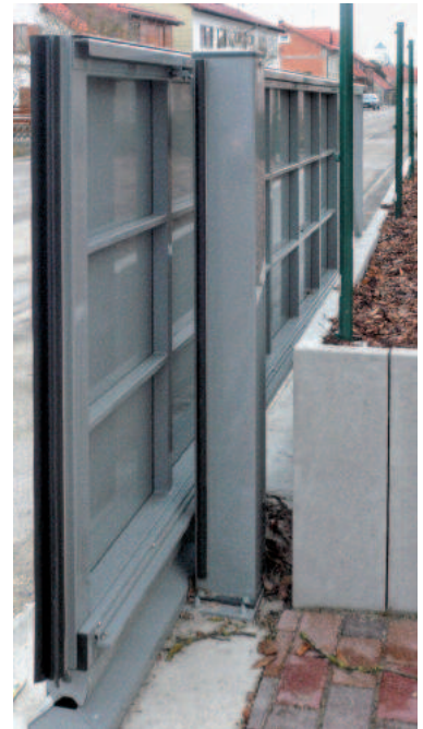
Torantrieb und Steuerung sind in der Aluminiumsäule untergebracht
