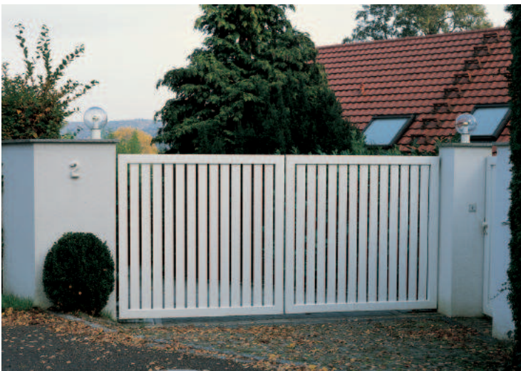
Korrosionsschutz durch Feuerverzinkung und Farbbeschichtung des Drehtores
