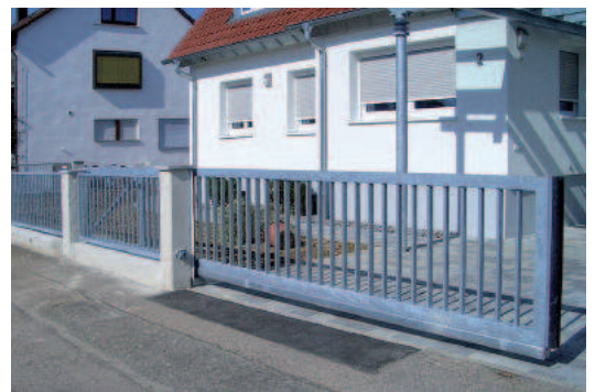
Freitragendes Hof-Schiebetor mit automatischem Antrieb
