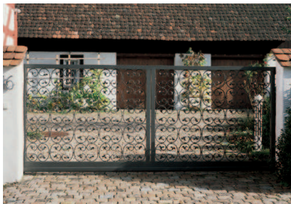
Hier wurde ein historisches Drehtor zu einem freitragenden Schiebetor mit Antrieb umgebaut
