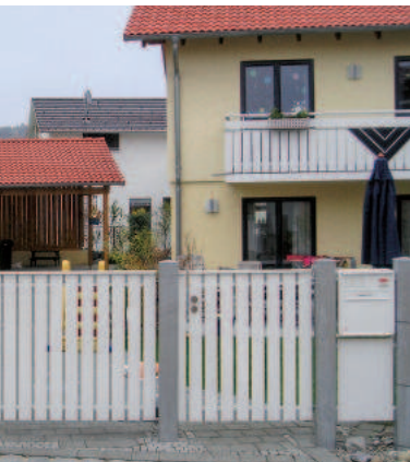
Hof-Drehtor aus Stahl mit pflegeleichteren Kunststoffprofilen
