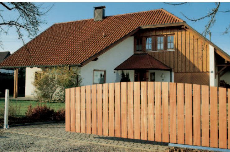
Hier wurde ein historisches Drehtor zu einem freitragenden Schiebetor mit Antrieb umgebaut
